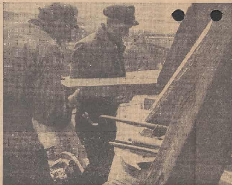
Hoch über den Dächern von Leer wird über schwindelnder Höhe der Turmhelmer der Lutherkirche renoviert.
