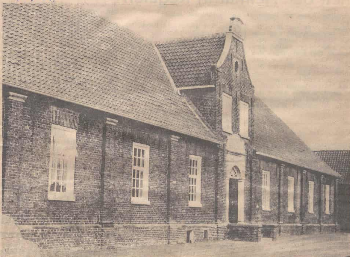
Die Straßenfassade des alten „Gasthauses“ blieb erhalten
