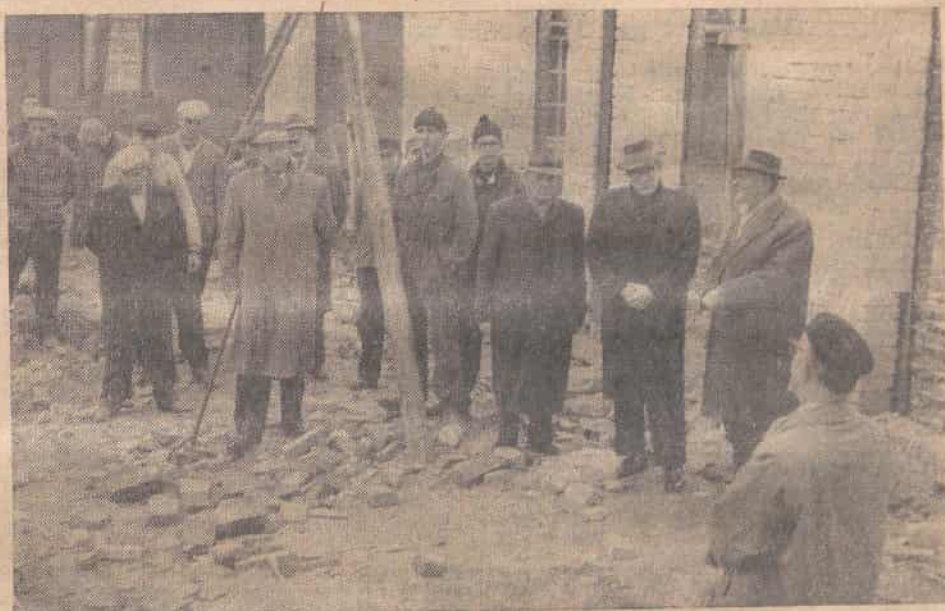
An dem neugebauten Ostflügel des Gemeindehauses ist noch viel zu tun, bis hier ein schmucker Gemeindesaal entstanden ist. Aber gestern wehte über dem Dachgebälk der Richtkranz, wofür Pastor Meyberg (im Vordergrund rechts) den Bauhandwerkern seinen Dank aussprach.
