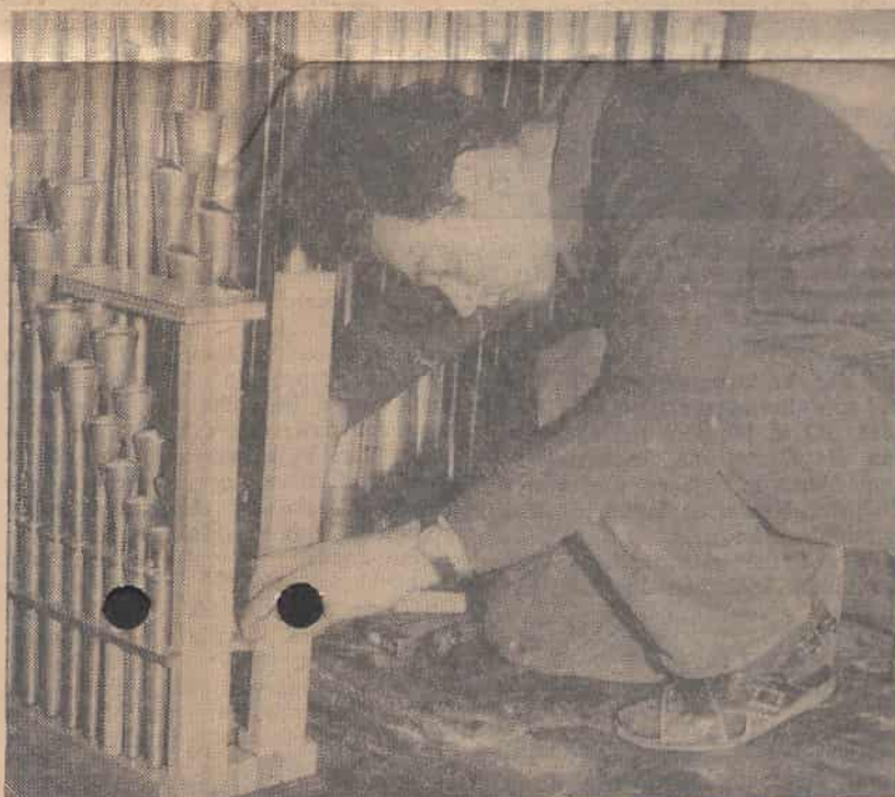
In einem Raum der Kirche wurde eine kleine Werkstatt eingerichtet. Hier fügen zwei Orgelbauer die von der Herstellungsfirma in Wilhelmshaven nach Leer gesandten Einzelteile zusammen.
